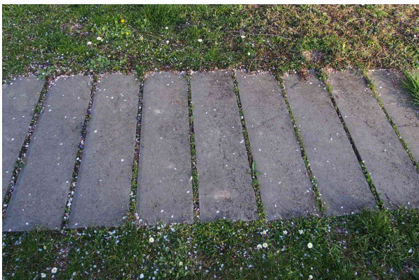
Navržená zpevněná plocha z betonových pásků.
